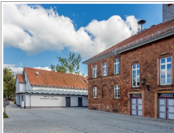
Blick auf das FWG mit Anbau Holzpelletanlage
