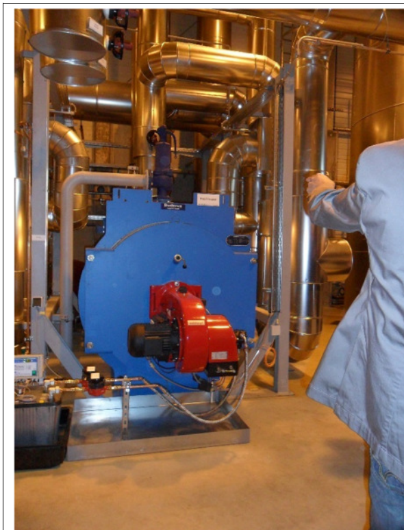
Holzhackschnitzelkessel 1,1 MW
